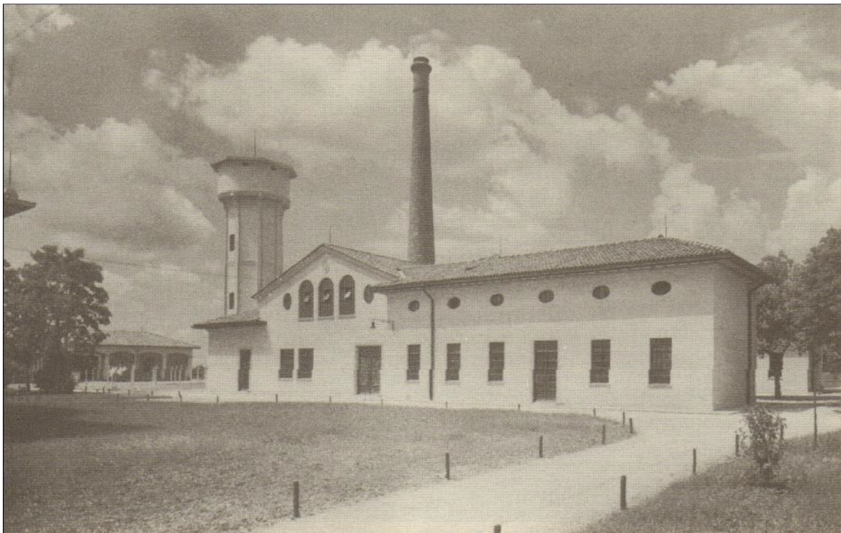
la lavanderia, immagine tratta dal secondo progetto per la ristrutturazione del comprensorio: (periodo 1928-1935)
